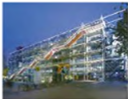
Le centre Pompidou
